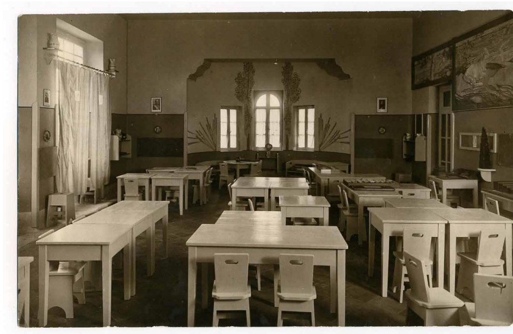
Fig. 21. L'aula della Scuola di Scauri. MuSEd, Fondo Ente Scuole per i contadini. Raccolta fotografica. Aule di edifici scolastici, img. 306.1
