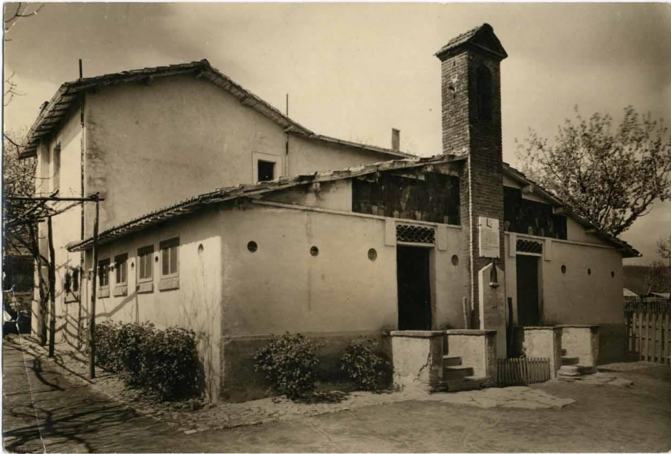
Fig. 13. L'ampliamento della scuola di Colle di Fuori del 1924. MuSEd, Fondo Ente Scuole per i contadini. Raccolta fotografica. Esterni di edifici scolastici. Esterni di edifici scolastici, img. 314.23
