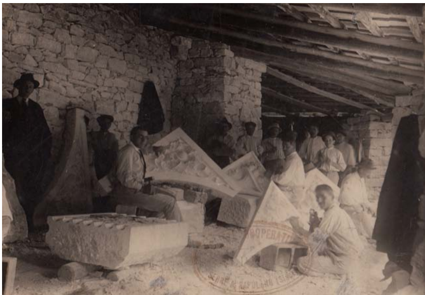
fig. 1 - Il cantiere della società “ Scalpellini Paradiso” agli inizi del secolo scorso, s.d., archivio Travertini Paradiso Srl – Gruppo Dei.
