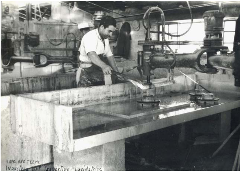
Fig. 4 - Operaio addetto a una macchina lucidatrice in uno stabilimento di Rapolano Terme, anni cinquanta, s.d., foto Calamati, archivio della Camera di Commercio di Siena.
