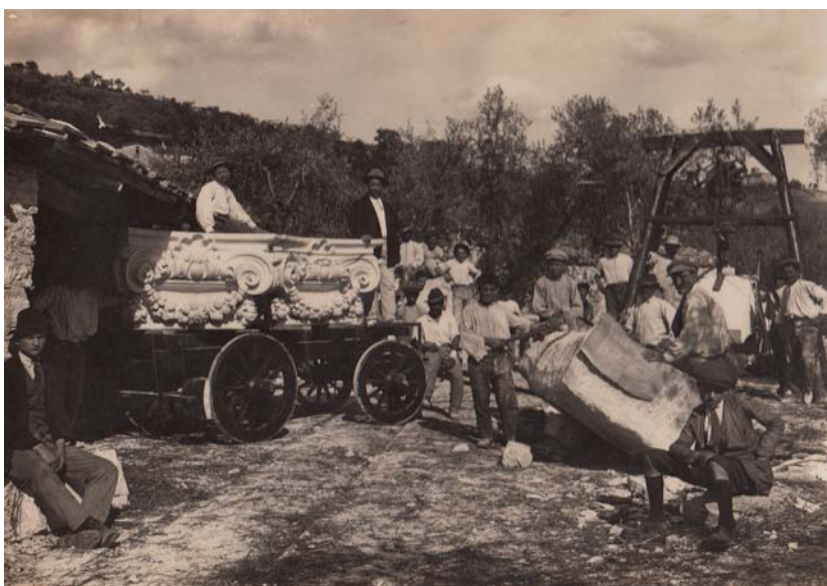
fig. 2 - Movimentazione e trasporto su barrocci dei fregi in massello agli inizi del secolo scorso, cantiere della società “ Scalpellini Paradiso”, s.d., archivio Travertini Paradiso Srl – Gruppo Dei.
