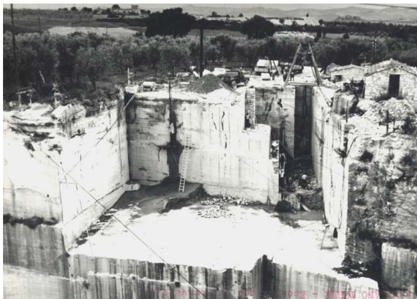
fig. 5 - Cava di travertino attiva negli anni cinquanta in località Le Serre di Rapolano, s.d., foto Calamati, archivio della Camera di Commercio di Siena.
