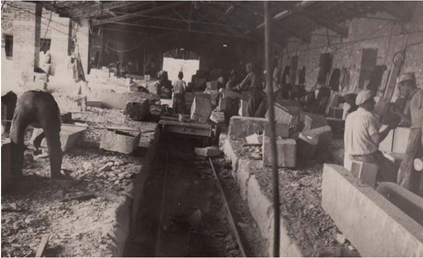
fig. 3 - Lavorazione dei blocchi di travertino in un cantiere di Rapolano Terme, s.d., archivio Travertini Paradiso Srl – Gruppo Dei.
