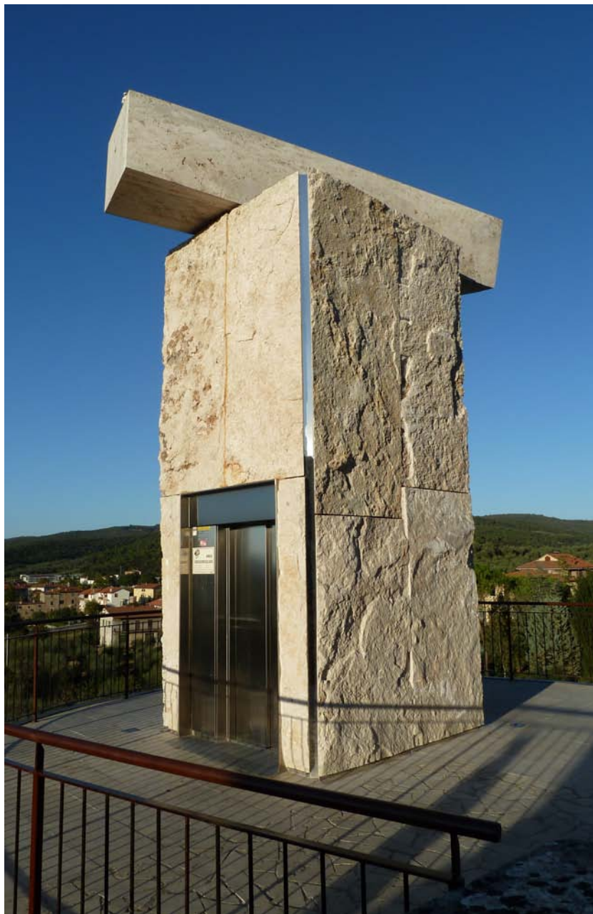
fig. 15 - L'ascensore in travertino progettato dallo scultore Jean-Paul Philippe, Rapolano Terme, particolare, foto Lusini, 2012.
