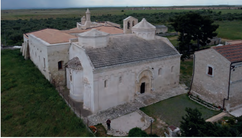
Fig. 2 - Siponto, chiesa di San Leonardo, veduta aerea (foto A. D'Ardes).
