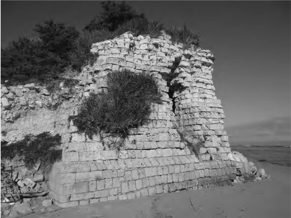
Figura 15 - La profonda erosione del litorale ha intaccato il piede della Torre Fiumicelli (comune di Otranto), un tempo quasi del tutto sepolta da un rilevato cordone dunare.
