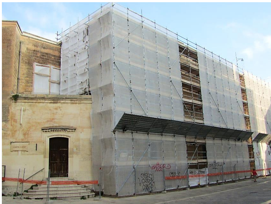
Fig. 1 – Lecce, L'ospedale dello Spirito Santo in fase di ristrutturazione , VII/2017.
